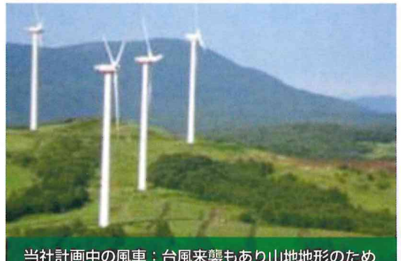
当社計画中の風車：台風来襲もあり山地地形のため 57m/s が設計速度とした。
