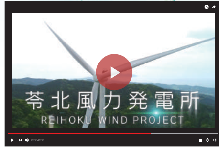
苓北風力発電所（7.5MW）紹介動画
