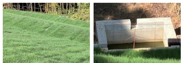
弊社、苓北風力発電所における緑化による保護（左）と沈砂池（右）
